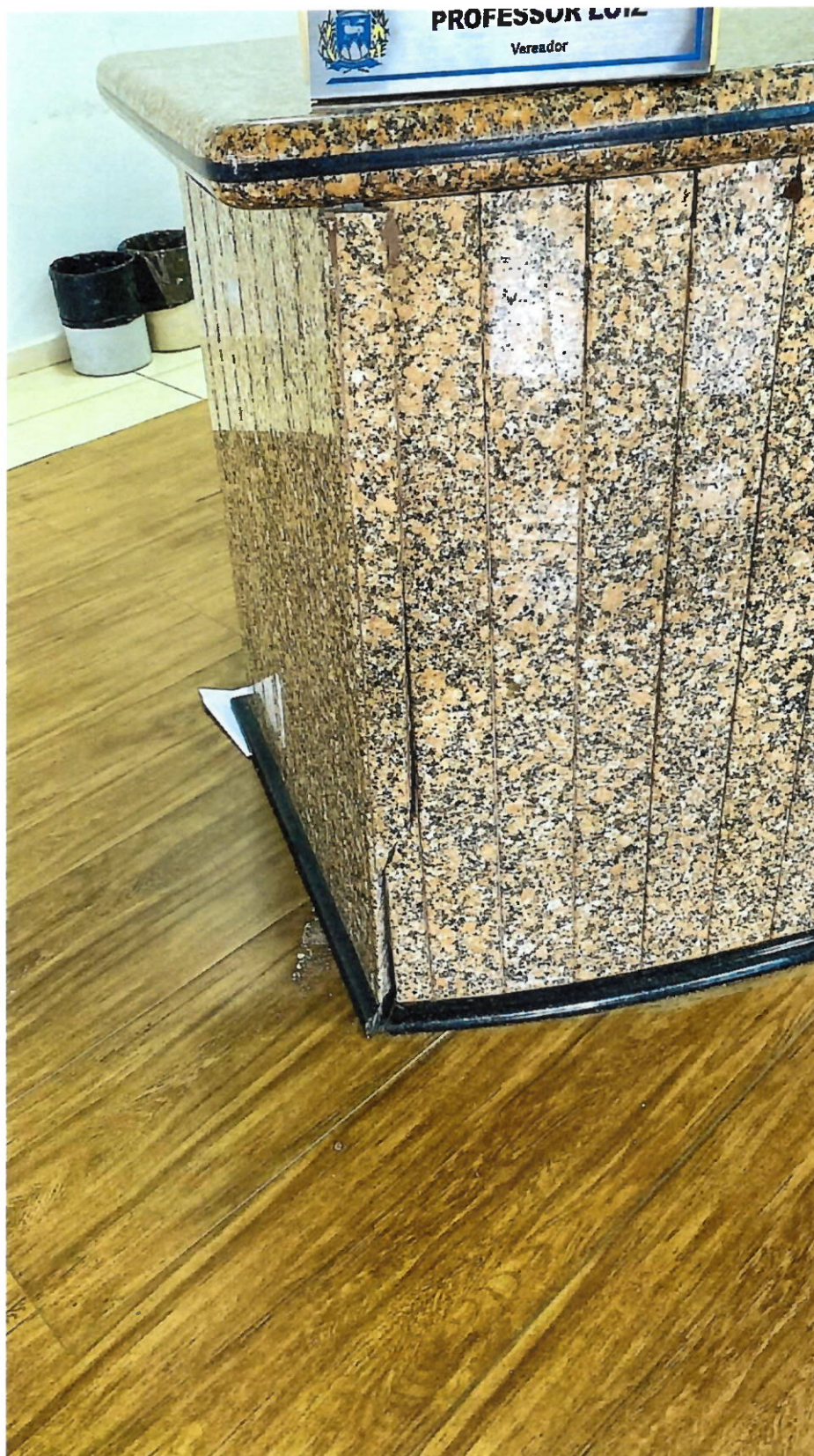
Mesa vereadores trincada e solta – risco de cair o tampão
